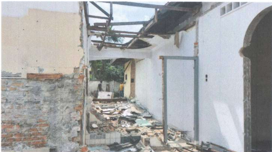
Pembongkaran Kusen Eksisting
