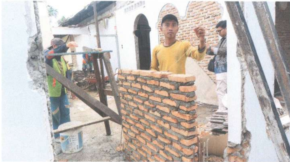
Pemasangan Dinding Bata Baru
