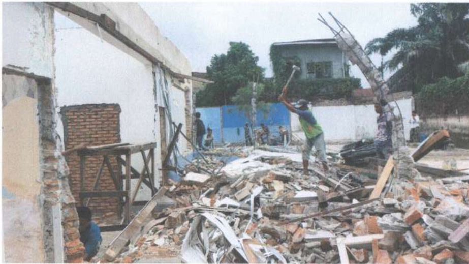
Pembongkaran Dinding Eksisting
