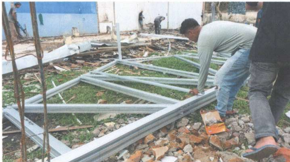
Perangkaian Rangka Atap Baja Ringan
