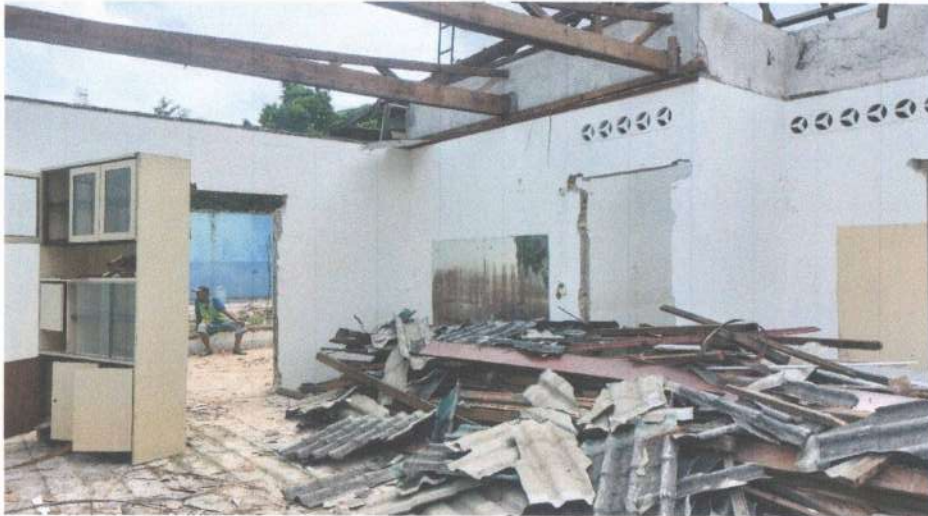
Pembongkaran Atap Eksisting
