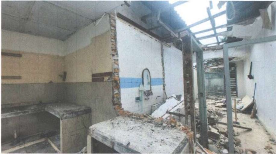
Pembongkaran Dinding Eksisting
