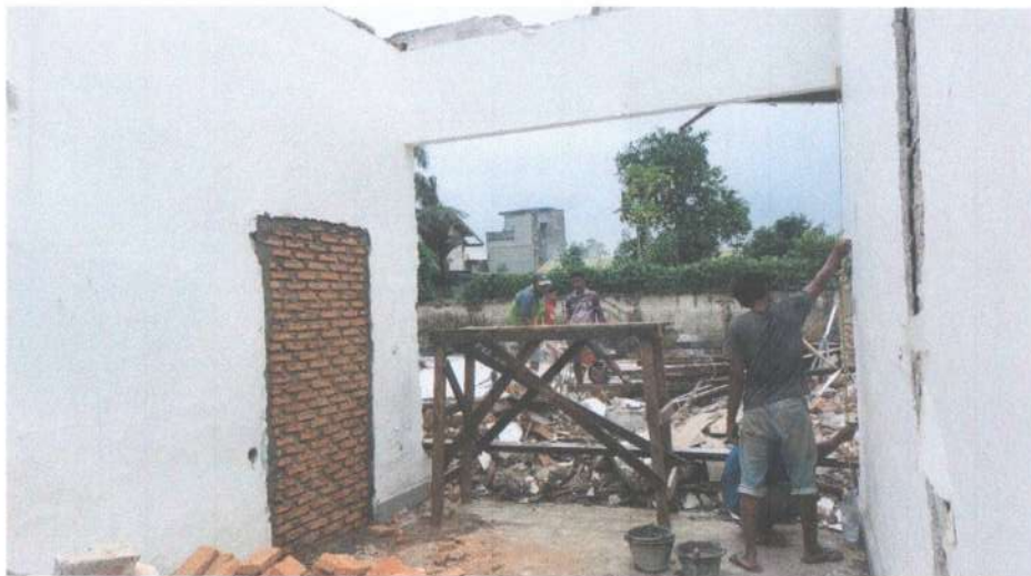
Pemasangan Dinding Sisip Bata
