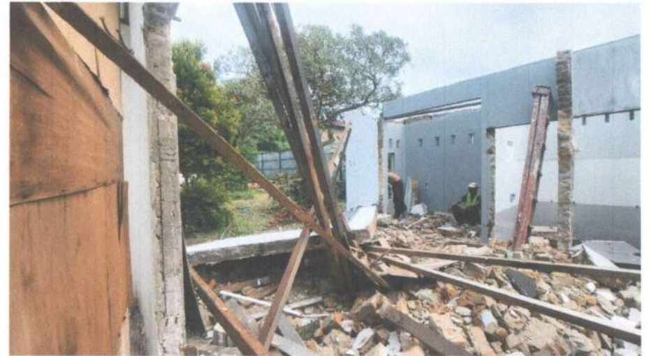
Pembongkaran Dinding Eksisting
