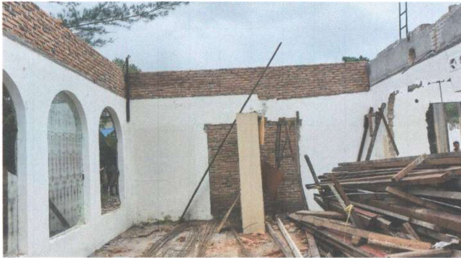
Pemasangan Dinding Baru Pada Bagian Ring Balok
