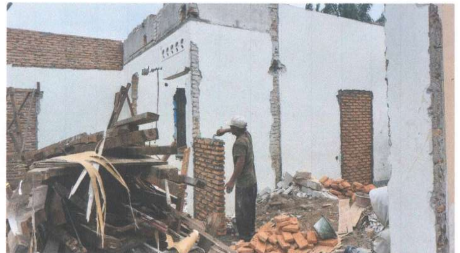
Pemasangan Dinding Bata Baru
