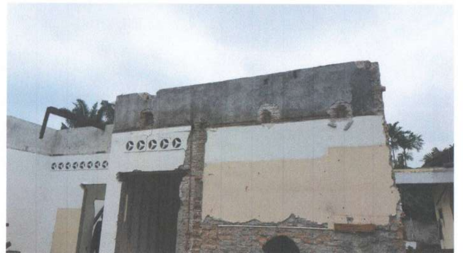
Pembongkaran Atap Eksisting
