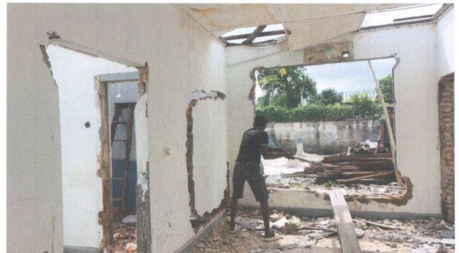
Pembongkaran Dinding Eksisting
