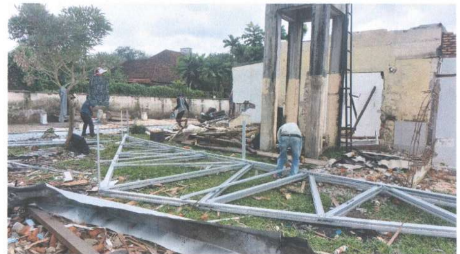
Perangkaian Rangka Atap Baja Ringan
