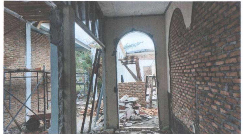
Pemasangan Dinding Sisip Bata
