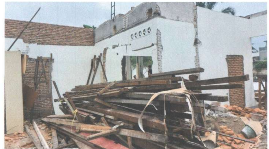
Pemasangan Dinding Baru Pada Bagian Ring Balok
